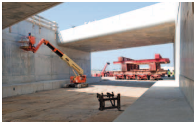
Bouw viaduct Leidsche Rijn. Foto: Gerit Serne
